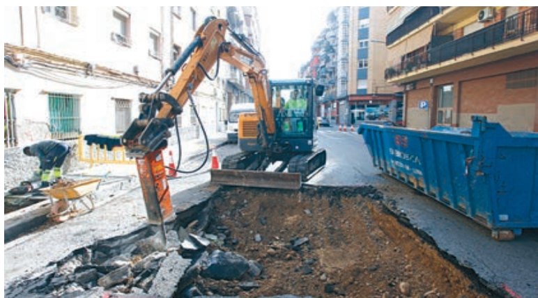
FOTO_ Tony Alcántara i A.C. Uns operaris treballen en la reparació de la xarxa d'aigua i imatge en primer pla de l'esvoranc del paviment
