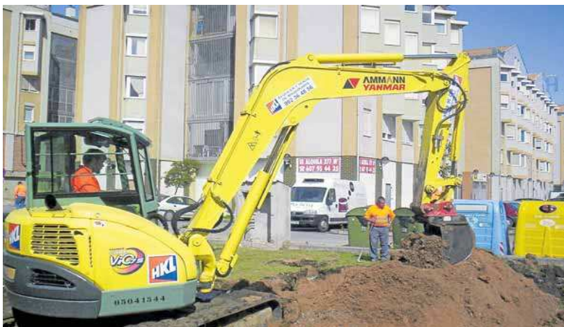
Una pala excavadora trabaja en una urbanización de Bezana. JAVIER COTERA
