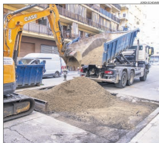
Tras reparar la avería se tapó el agujero con tierra.
