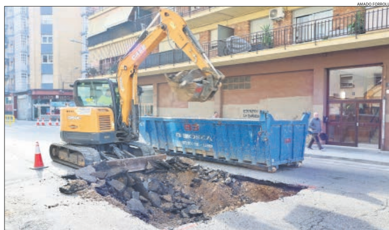
La excavadora ensanchó el socavón para que técnicos de Aigües de Lleida identificaran la fuga.
